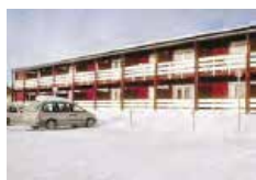
Idre Ski-apartment Lägenhet i huvudbyggnaden, 4 bäddar, 1ES, 2NV, 2BS, 1DU, 1WC, MK, DS+VS Gemensamt torkrum. Prisklass 3 Centrum Nyrenoverad
