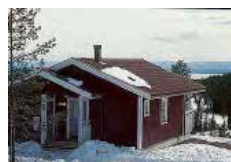
OG4 53 kvm, 6+2 bäddar, 2 sovrum (DS, 2VS) Storstuga/kök med bäddsoffa, kabel-TV, dusch, WC, bastu, torkskåp, fullständig köksutrustning, altan. Vissa hus är fristående, andra parhus. Prisklass B
